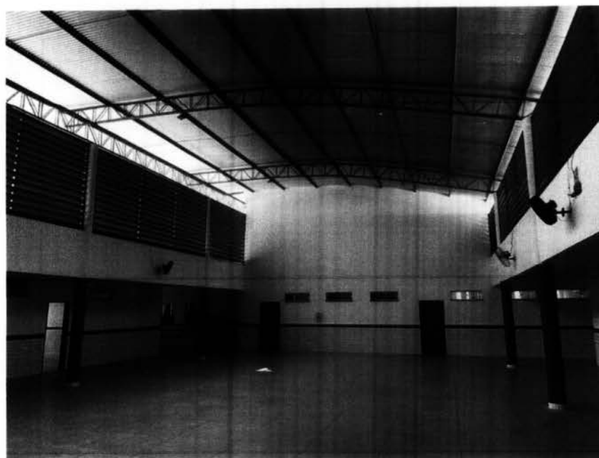
Imagem 5 – Pintura interna do pátio coberto.
