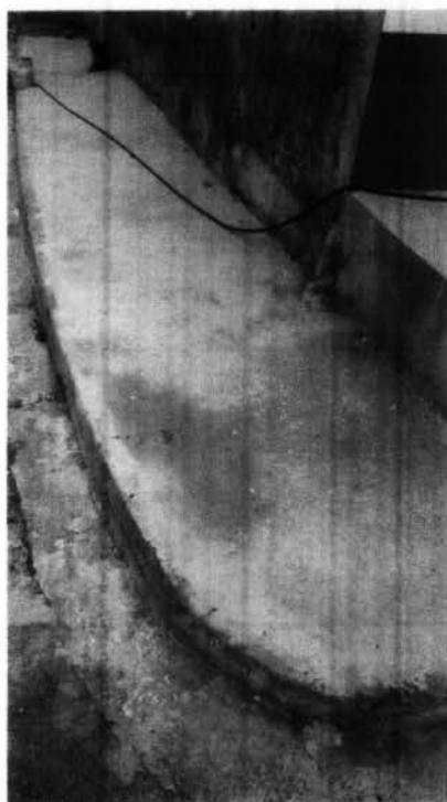
Imagem 10 – Execução da calçada externa da escola.
