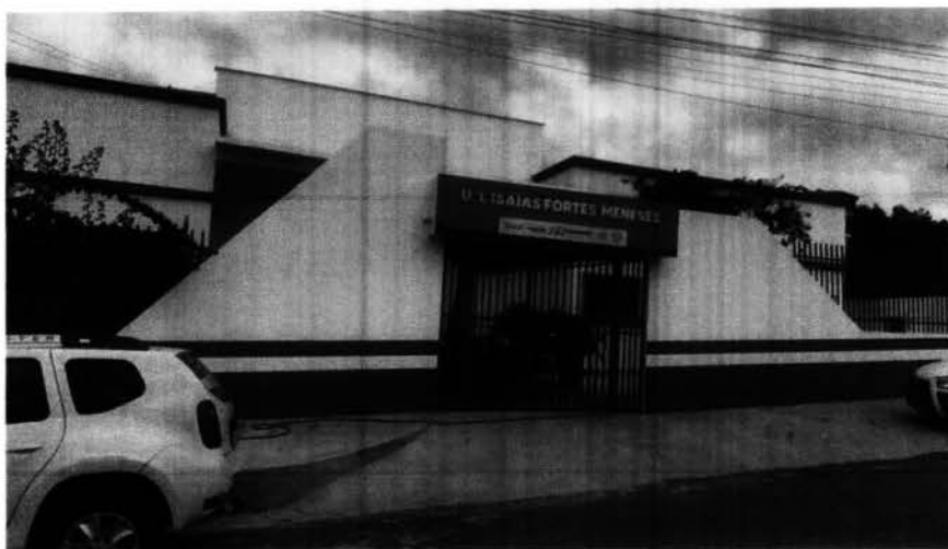
Imagem 1 – Pintura da fachada da escola.
