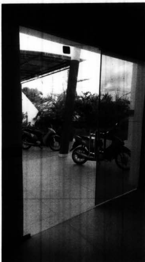
Imagem 7 – Substituição da porta de vidro quebrada
