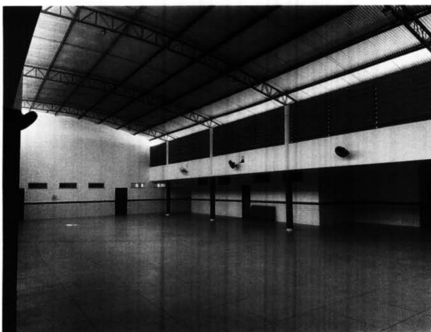
Imagem 4 – Pintura interna do pátio coberto.
