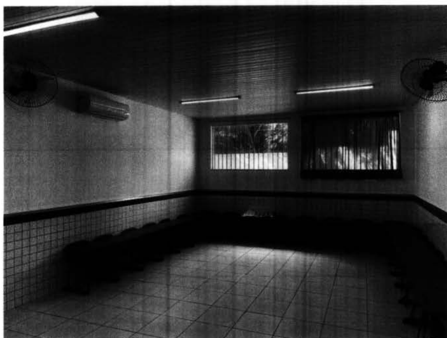
Imagem 8 – Execução de pintura interna das salas de aula.
